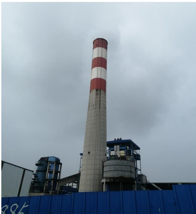
图 3.2-7 锅炉废气处理系统及排放烟囱
